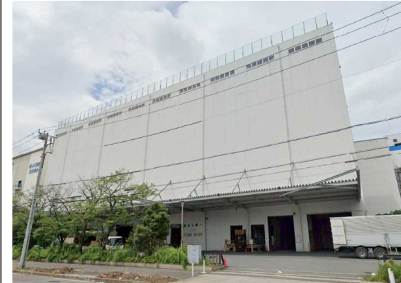
Y倉庫（東京都）7,800m 2 LED工事
