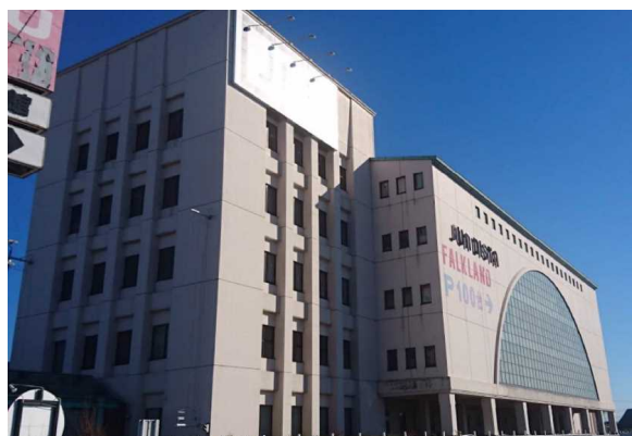
F商業施設（茨城県）6,600m 2 空調工事
