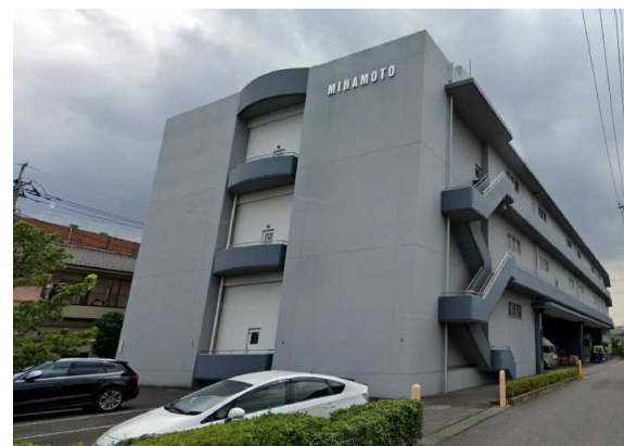
M倉庫（埼玉県）3,400m 2 LED工事
