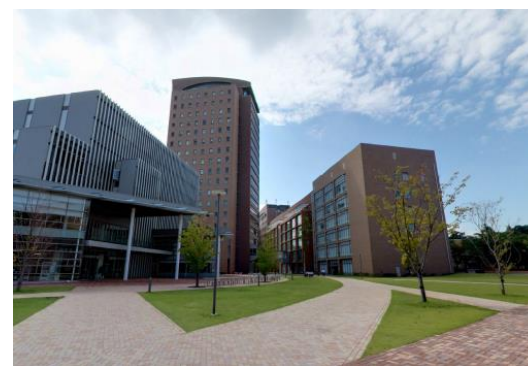
W大学（千葉県）45,000m 2 LED、電源工事
