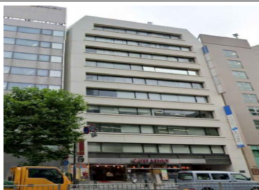
Sビル（東京都）3,341m 2 空調、LED工事 補助率1/2
