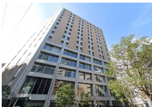
T大学（東京都）19,232m 2 空調、LED工事 補助率1/2
