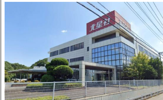
H工場（埼玉県）6,909m 2 空調、LED工事 補助率1/3
