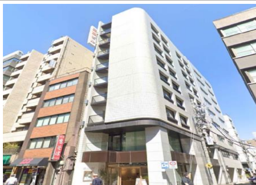
Sビル（東京都）4,656m 2 空調、LED工事 補助率1/2
