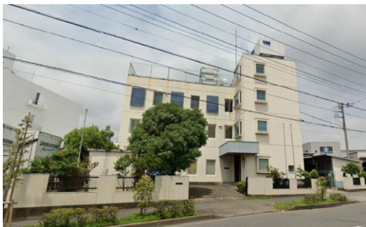
Y工場（東京都）1,351m 2 空調、コンプレッサ、チラー、受変 電設備工事 補助率3/4
