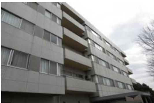
D病院（東京都）8,250m 2 空調、コジェネ工事 補助率1/2 ESCO事業
