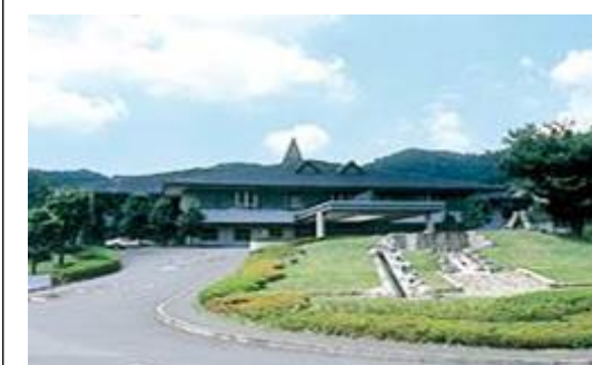
SJゴルフクラブ（栃木県）4,330m 2 空調、LED、発電機、EMS工事 補助率1/2
