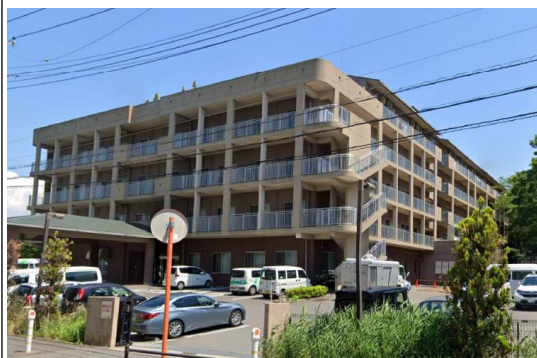
M老健施設（千葉県）10,328m 2 空調、受変電設備工事
