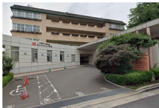
D老健施設（東京都）6,333m 2 空調、コジェネ工事 補助率1/2 ESCO事業
