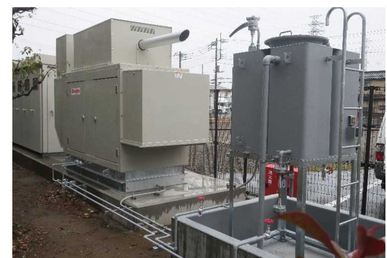
発電機（BCP対応）
