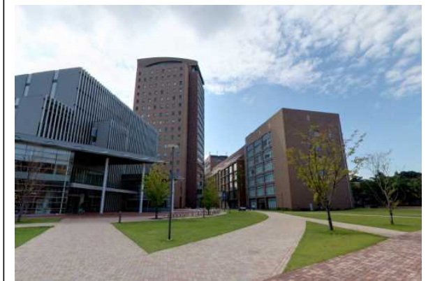
W大学（千葉県）45,000m 2 LED、電源工事
