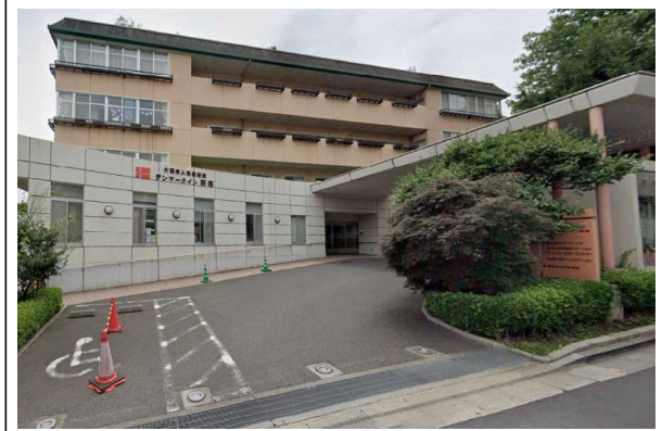
D老健施設（東京都）6,333m 2 空調、コジェネ工事 補助率1/2 ESCO事業
