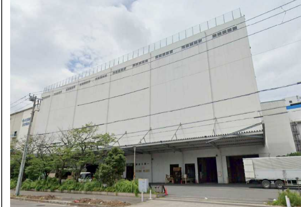
Y倉庫（東京都）7,800m 2 LED工事
