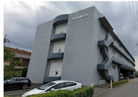
M倉庫（埼玉県）3,400m 2 LED工事
