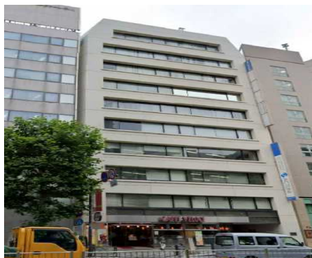
Sビル 空調・LED工事 1/2補助金 3,341m 2 東京都
