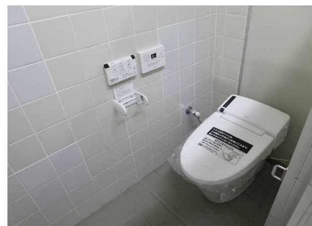
トイレリニューアル
