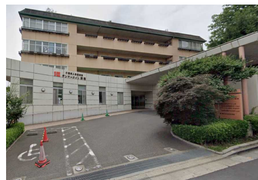
D老健施設 ESCO事業 空調・コジェネ工事 1/2補助金 6,333m 2 東京都
