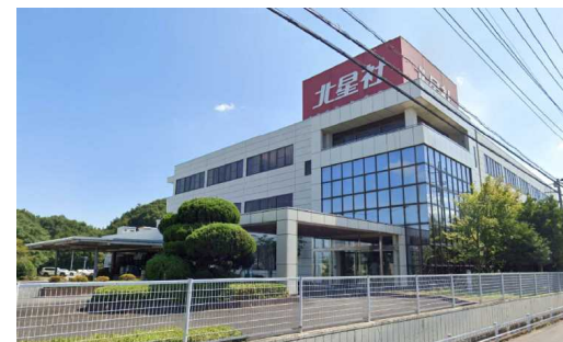
H工場 空調・LED工事 補助率1/3 6,909m 2 埼玉県
