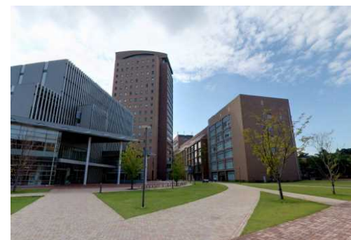
W大学 LED・電源工事 45,000m 2 千葉県
