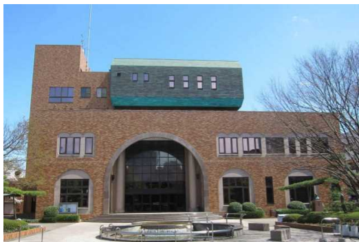
T大学 省エネ大賞受賞 事業調査、LED工事 補助率1/2 62,685m 2 千葉県
