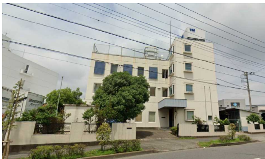
Y工場 空調・ｺﾝﾌﾟﾚｯｼｬ・ﾌﾚｰ・受変電設備工 事 補助率3/4 1,351m 2 東京都
