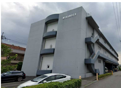
M倉庫 LED工事 3,400m 2 埼玉県
