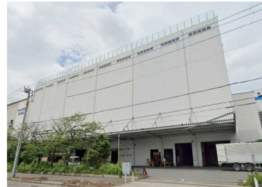
Y倉庫 LED工事 7,800m 2 東京都
