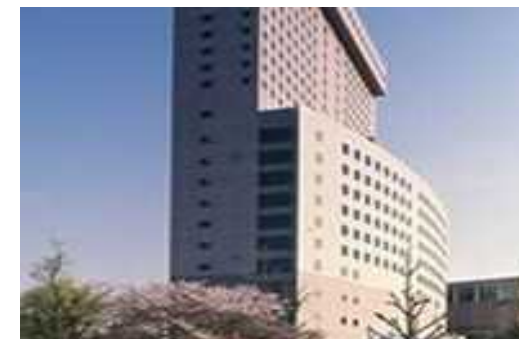
Kビル 省エネコンサルタント 47,372m 2 東京都
