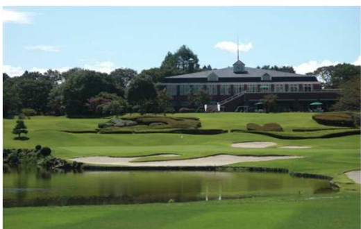
58ゴルフクラブ ZEB事業 バイオマスボイラ・空調・LED 太陽光、Low-e複層ガラス 補助率2/3 3,928m 2 栃木県
