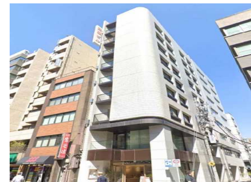
Sビル 空調・LED工事 1/2補助金 4,656m 2 東京都
